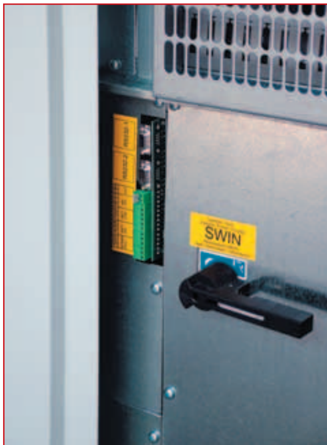
Detail datové svorkovnice
